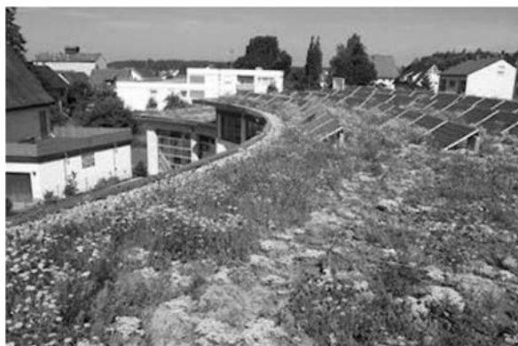
Obr. 2. Příklad extenzivní vegetační střechy [3]
